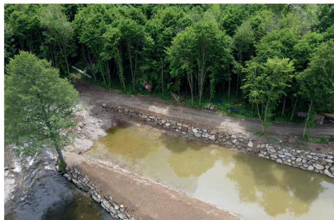
Ein wichtiger Bestandteil des neuen Konzepts war die Verlängerung des Auslaufkanals, was gerade im Hochwasserfall enorme Vorteile für das Kraftwerk bringt.
